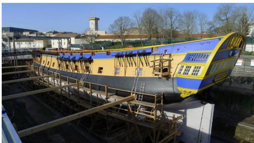
C'est le 4 juillet 1997 que l'association Hermione - La Fayette débute ce chantier de reconstruction à l'identique de la frégate à voile L'Hermione dans la double forme de radoub de l'ancien arsenal royal de Rochefort, en reprenant les techniques d'autrefois.
